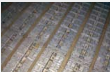
Als de filtervloer is gelegd, wordt hij grondig geïnspecteerd op montage en vlakheid.
