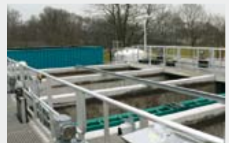
Met de 'bellentest' wordt goed zichtbaar hoe mooi gelijkmatig het lucht/watermengsel uit de underdrains komt.
